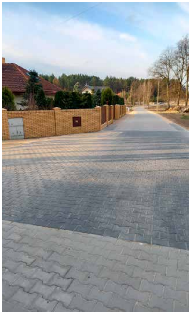
Zmodernizowana ul. Chmielna w Niewodnicy Kościelnej.
