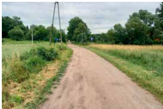
Droga w Stoczkach po przebudowie zyska nawierzchnię z kostki brukowej.
