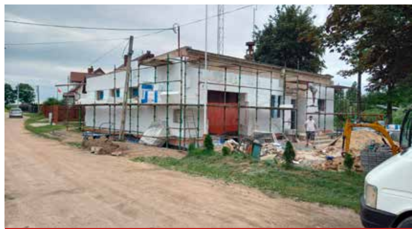
Trwają prace remontowe świetlicy w Iwanówce
