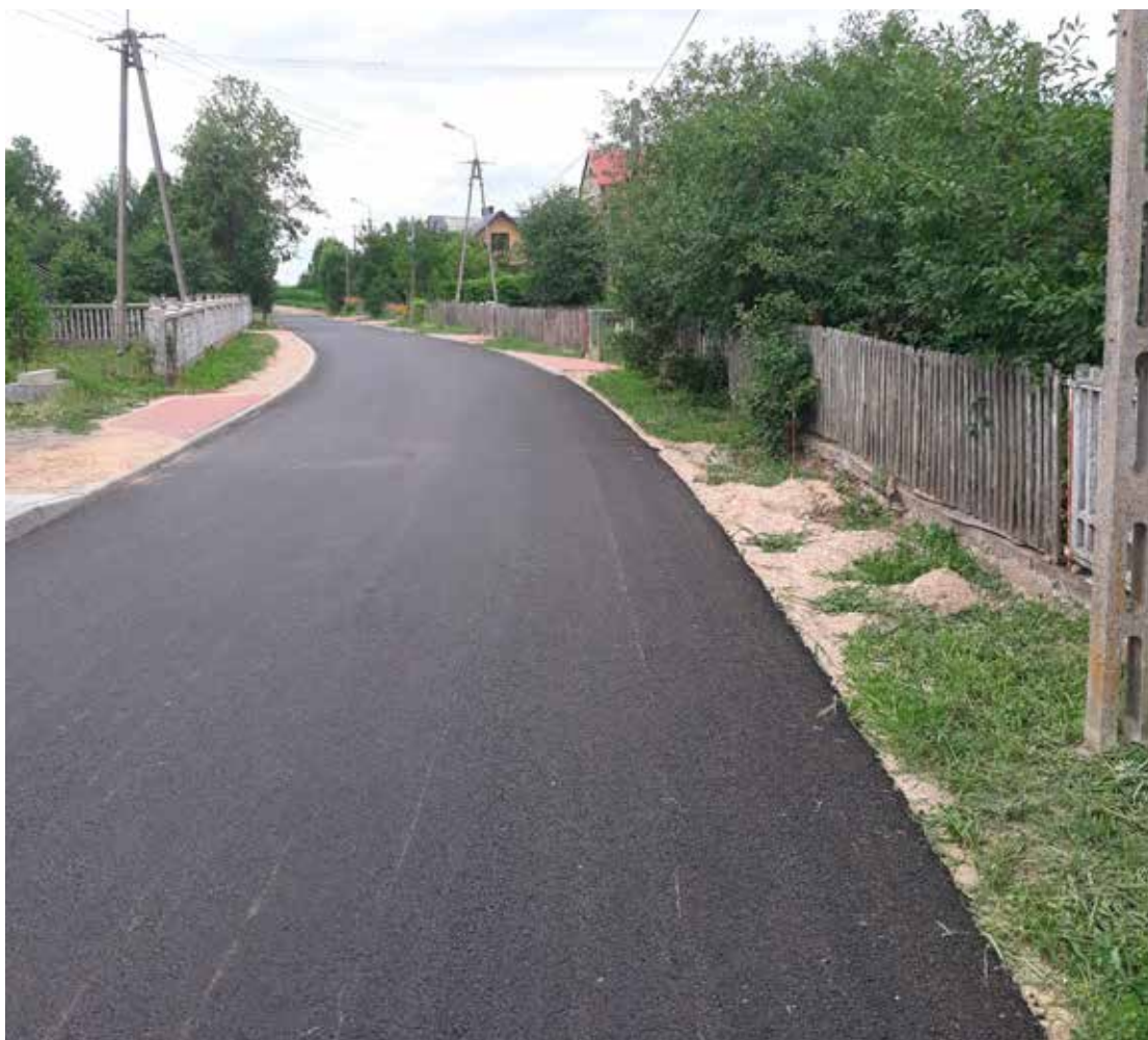
Przebudowa drogi była realizowana na odcinku ponad 0,7 km.
