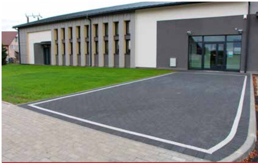
Nowo wybudowany chodnik przed świetlicą w Turośni Kościelnej.
