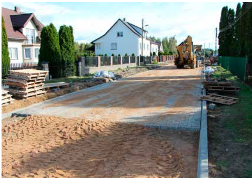
Droga gminna w Iwanówce w trakcie przebudowy.
