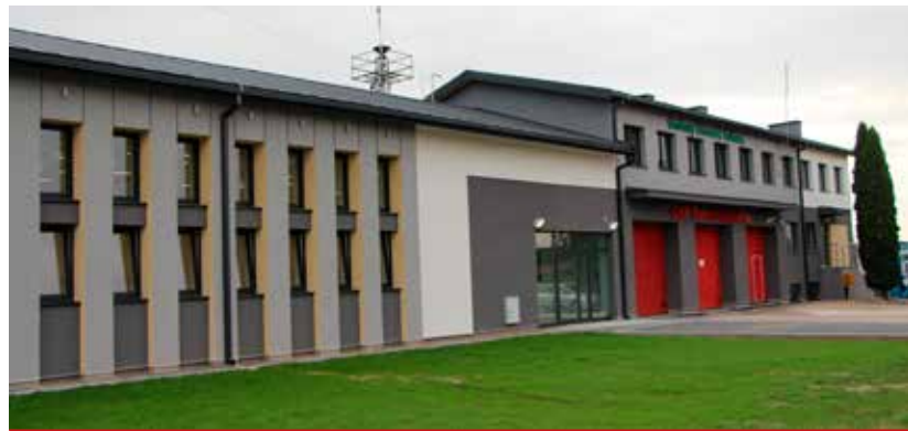
Świetlica w Turośni Kościelnej po termomodernizacji.
