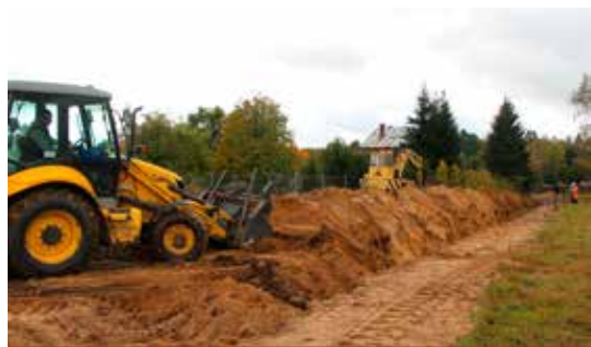
Prace nad rozbudową sieci wodociągowej w Zalesianach
