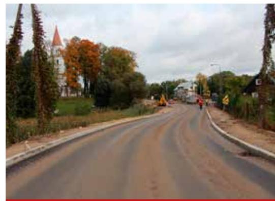
Pierwsza warstwa asfaltu na części przebudowanego odcinka drogi w Niewodnicy Kościelnej.
