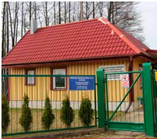
Budynek oczyszczalni w Turośni Kościelnej.
