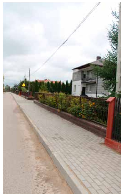
Wykonany dalszy odcinek chodnika przy ulicy Lipowej w Turośni Kościelnej.
