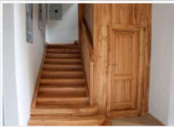
Schody wewnętrzne po remoncie.
