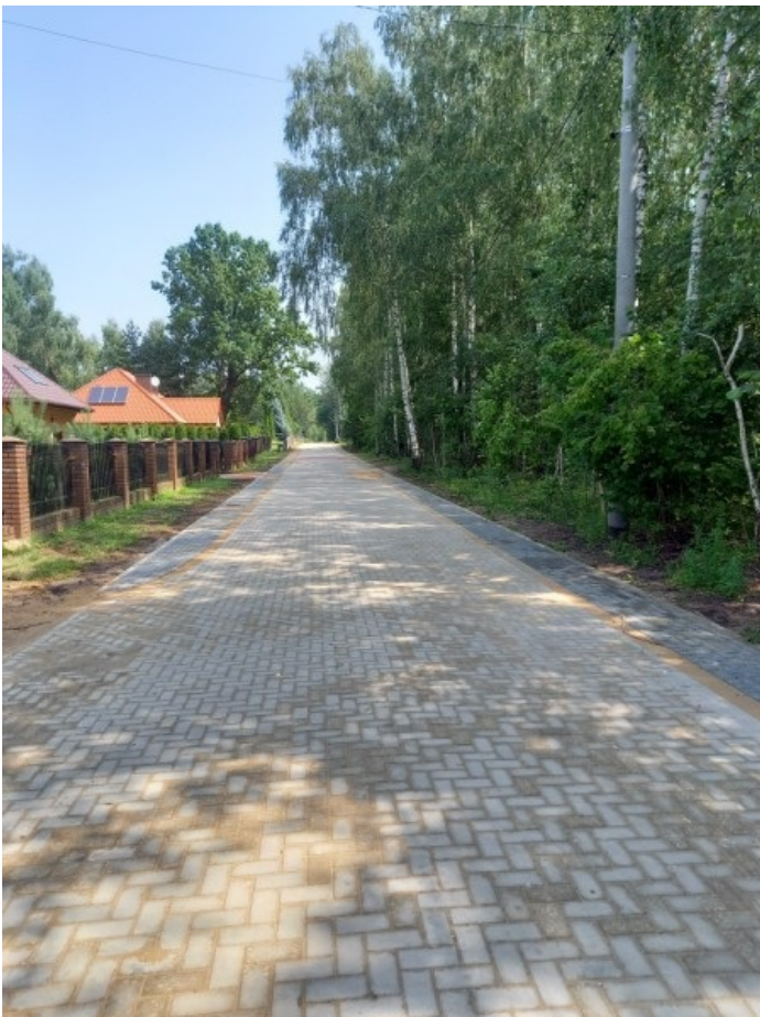
Ul. Polna w Niewodnicy Kościelnej po przebudowie ma nawierzchnię utwardzoną kostką betonową.
